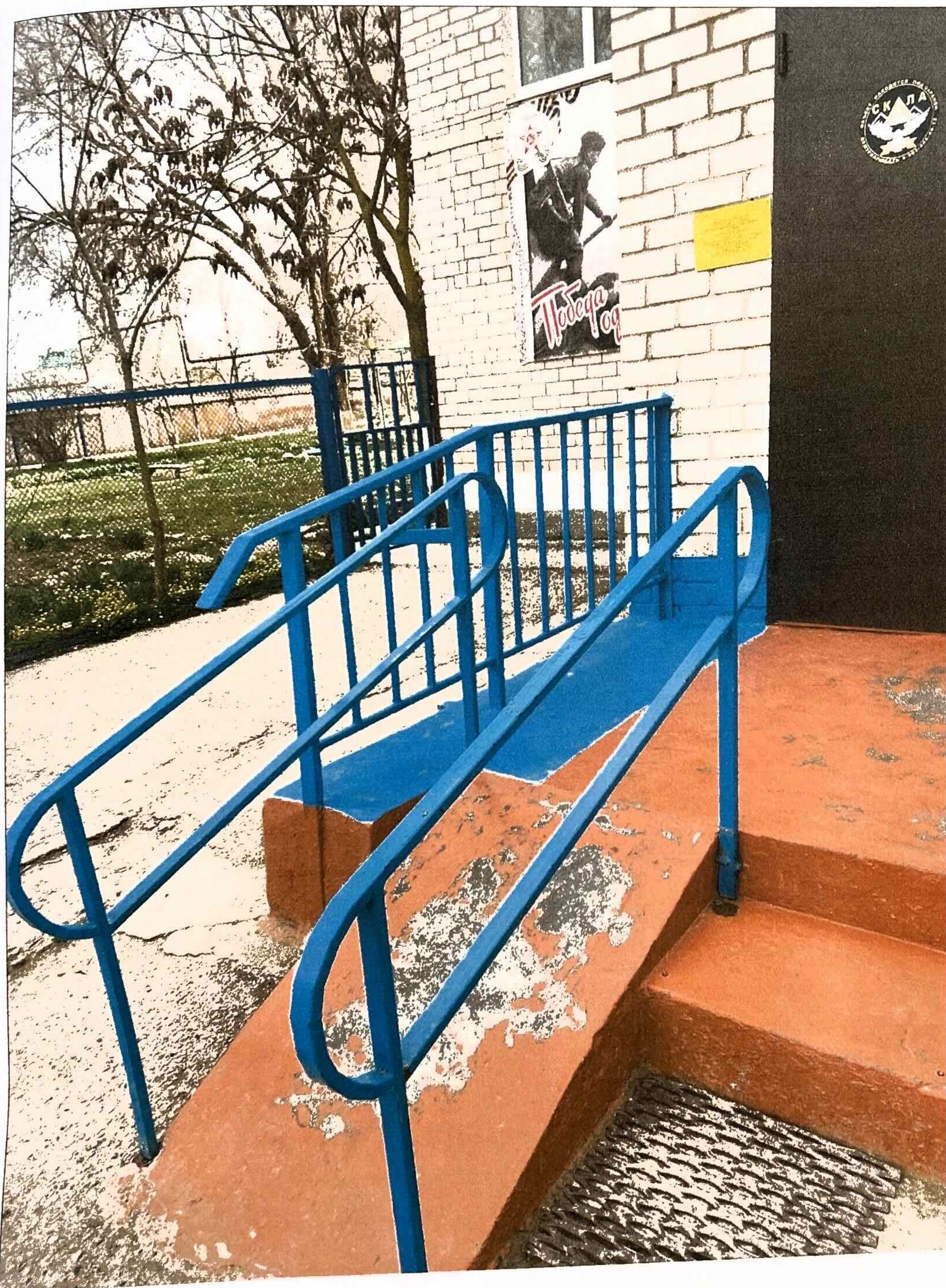
Пандус при входе в МКОУ СОШ №13
