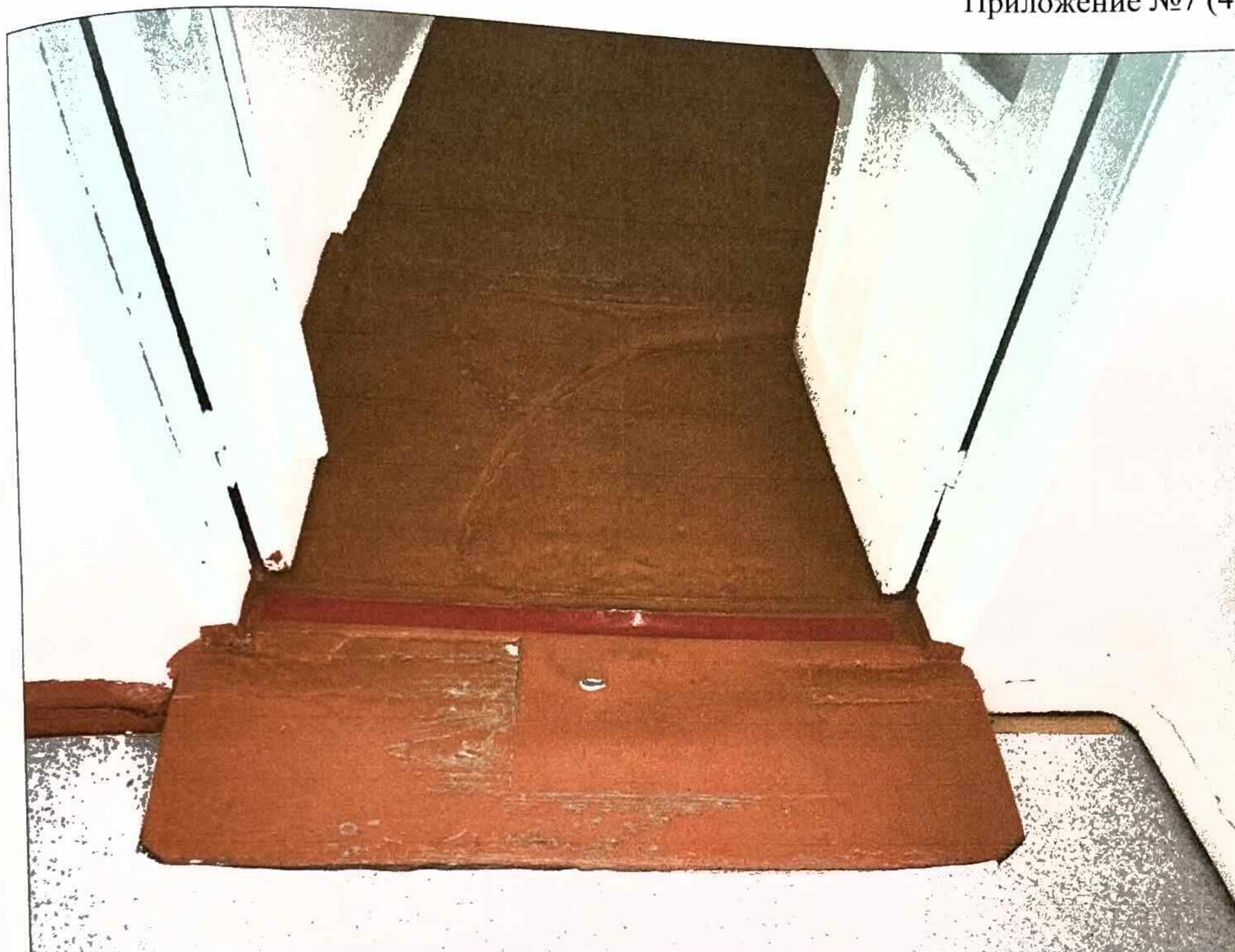
«Опасность» между коридорами школы
